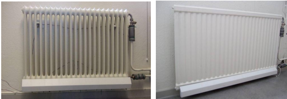
Figur 15: Radiatorfläkt monterad på sektionsradiator (till vänster) och panelradiator (till höger).
