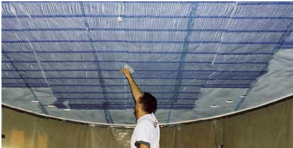
Figur 35: Kapillärörsmatta av polypropylen för vattenburen kyla/värme i taket 39 .
